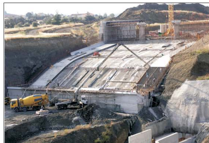
Υπερχειλιστής υπό κατασκευή - Spillway under construction
