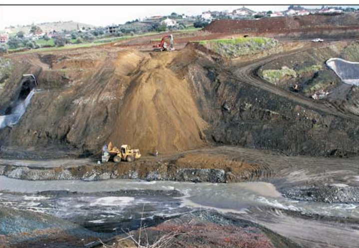
Γενική άποψη έναρξης εργασιών - Commencement of works
