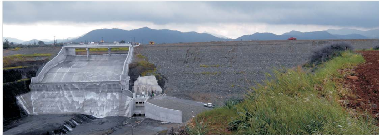
Πανοραμική άποψη υπερχείλισης του φράγματος - Panoramic view of overspilling of the dam
