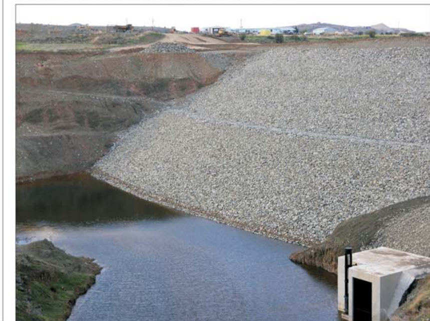
Ανάντι πρηνές και κατασκευή υδροληψίας - Upstream slope and intake structure
