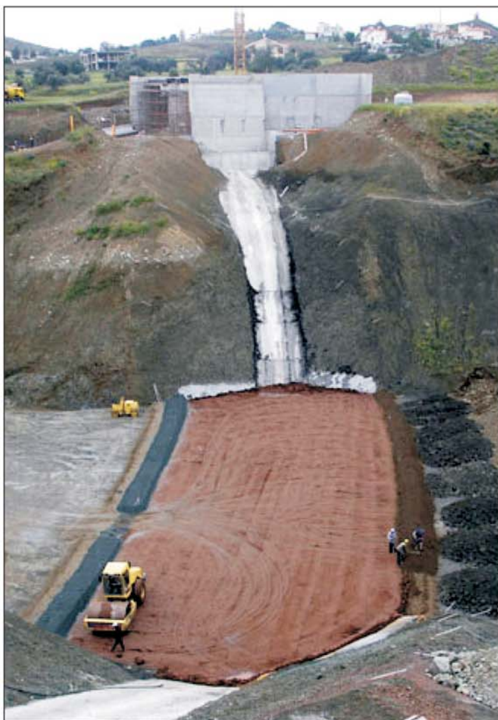
Κατασκευή αναχώματος - Construction of embankment
