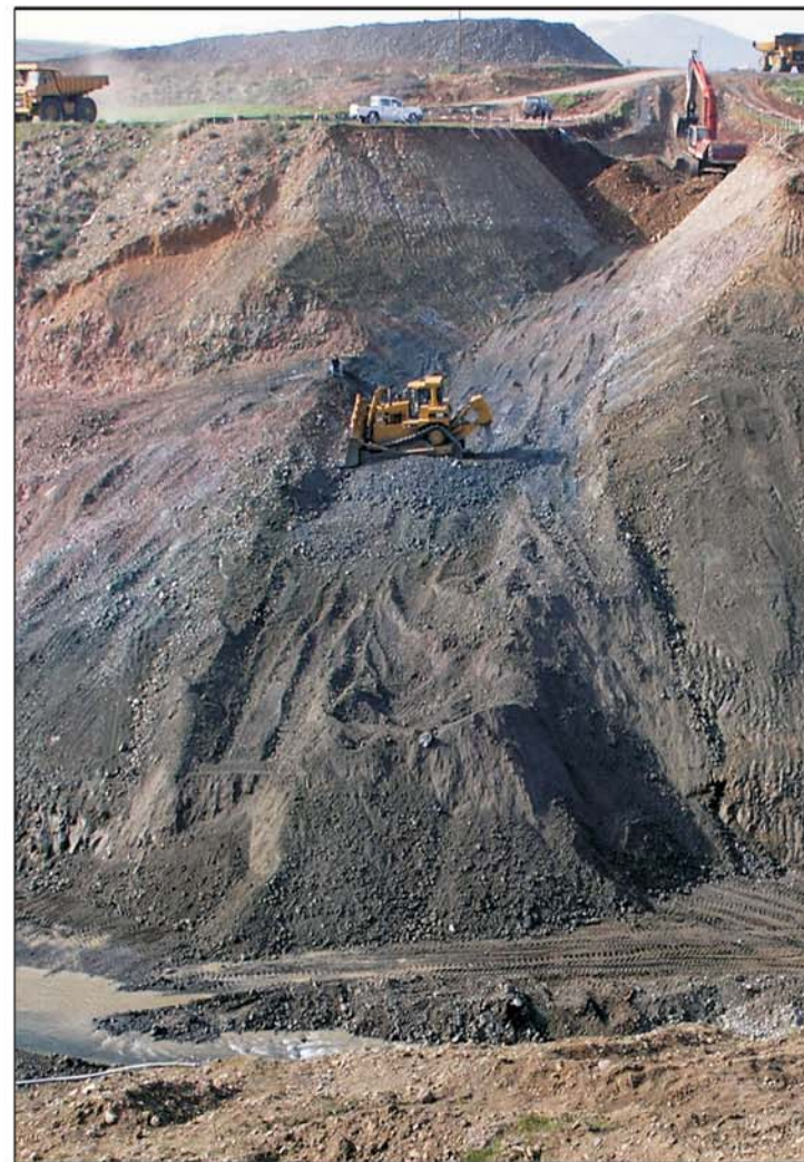
Εκσκαφή Θεμελίων - Core trench excavation
