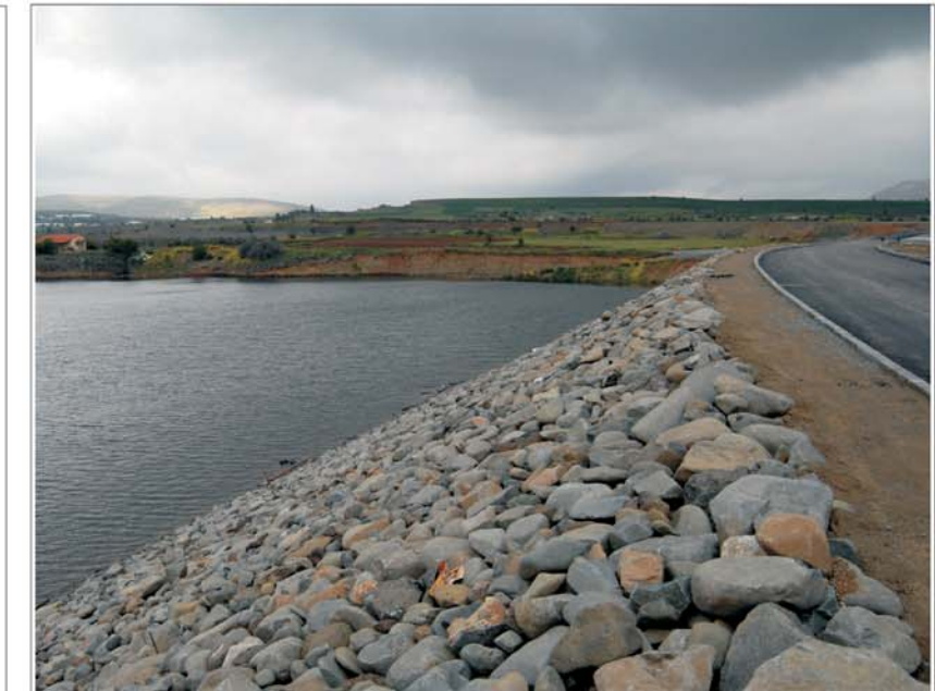
Λιθορριπή προστασίας ανάντι πρηνούς - Upstream rip - rap
