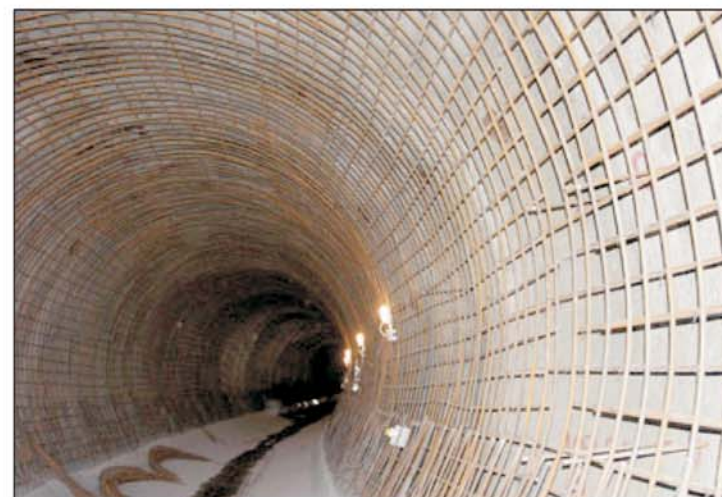
Οπλισμός στη σήραγγα εκτροπής-Reinforcement of diversion tunnel
