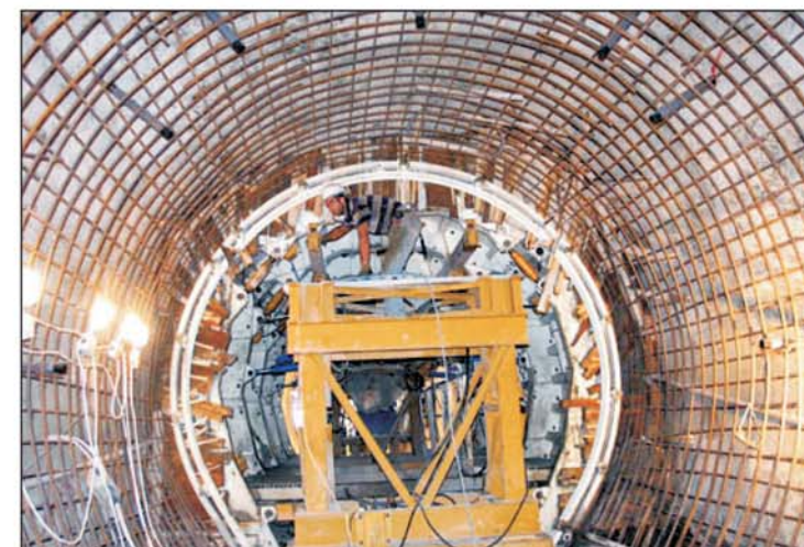
Μεταλλικό καλούπι στη σήραγγα εκτροπής -Metal formwork of the diversion tunnel
