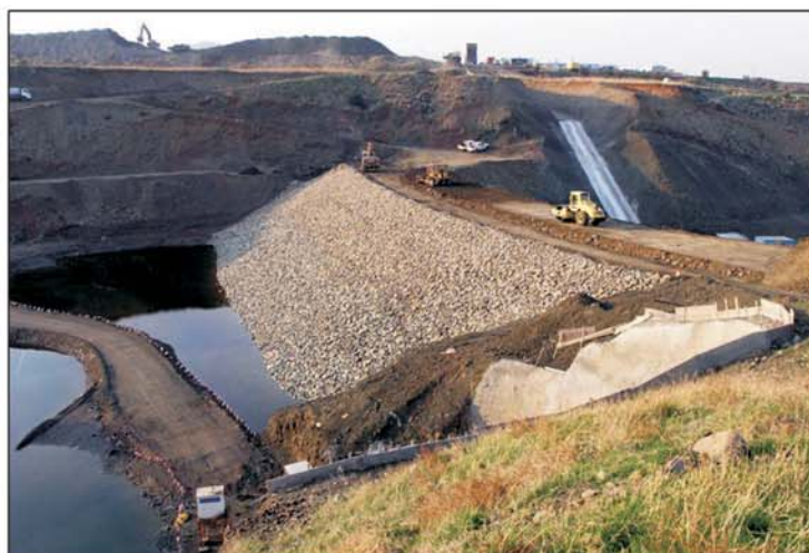
Κατασκευή προφράγματος - Construction of cofferdam
