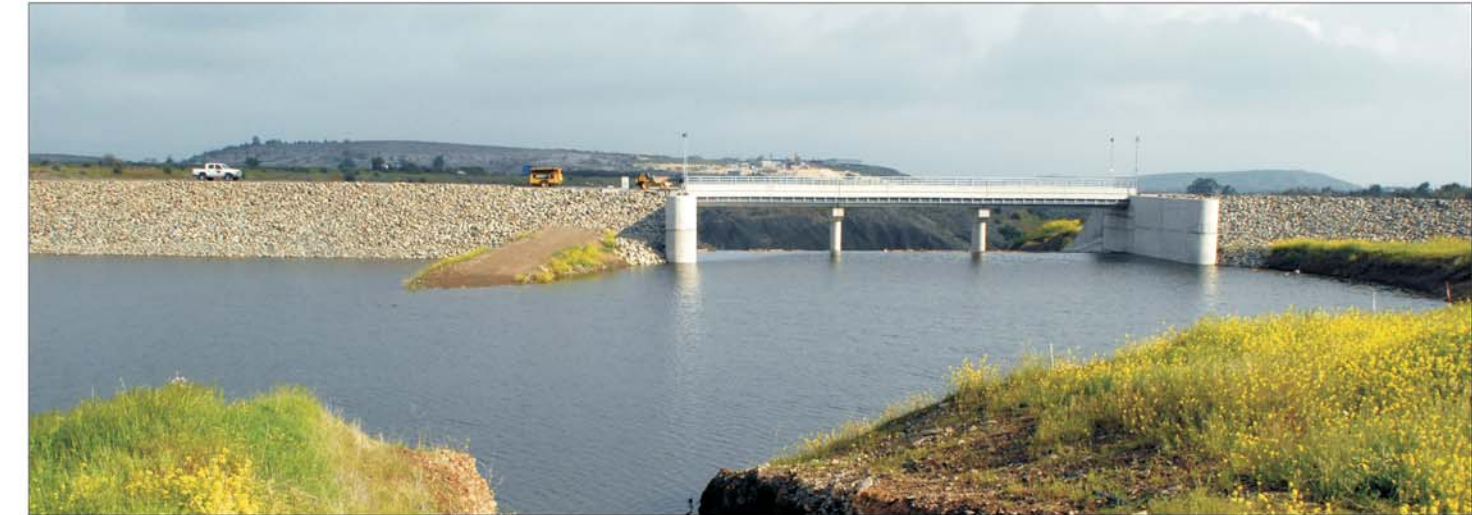
Γενική άποψη του φράγματος και του ταμιευτήρα - General view of dam and reservoir
