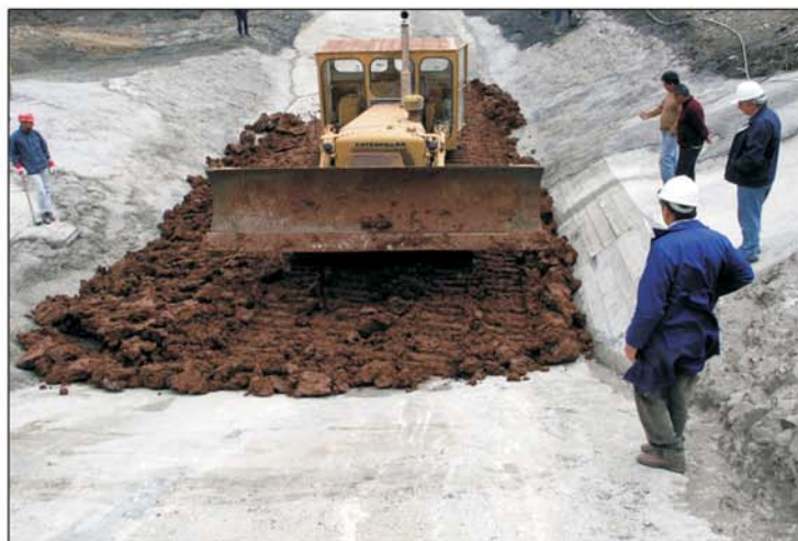
Κατασκευή αργιλικού πυρήνα - Placement of clay core
